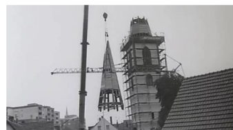
„Schäden durch Wurmfräß und Holzfaule“
